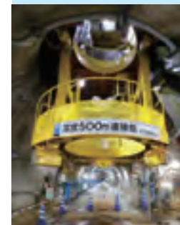
深度500m この奥の坑道に グラウチングを行った
