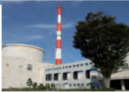
高速実験炉「常陽」
